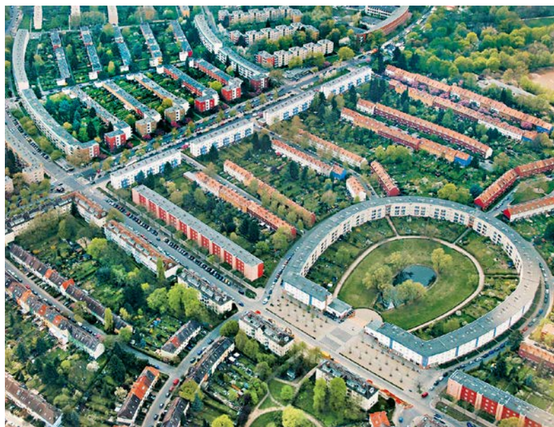
Die Berliner Großsiedlung Britz entstand in sieben Bauabschnitten nach Plänen von Bruno Taut. Gemäß der zentralen Baugruppe hat sich der Name „Hufeisensiedlung“ durchgesetzt
